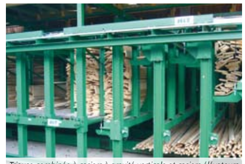
Trieuse combinée à casiers à gravité verticale et casiers élévateurs
